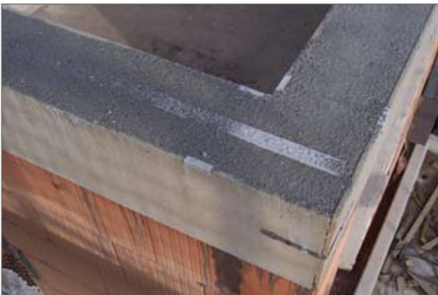
Ausildung eines Ringankers mit vor Ort eingelegter Ankerschiene
